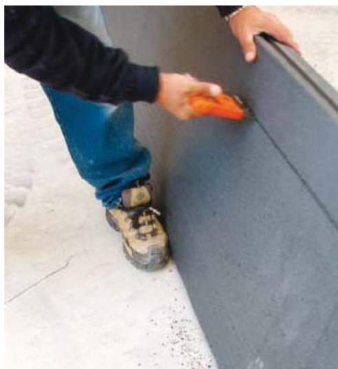
3 Cięcie płyty na wysokości metalowego profilu
