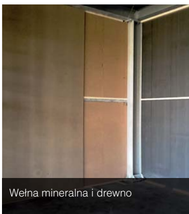
Ścianka działowa z płyty gipsowo-kartonowej
