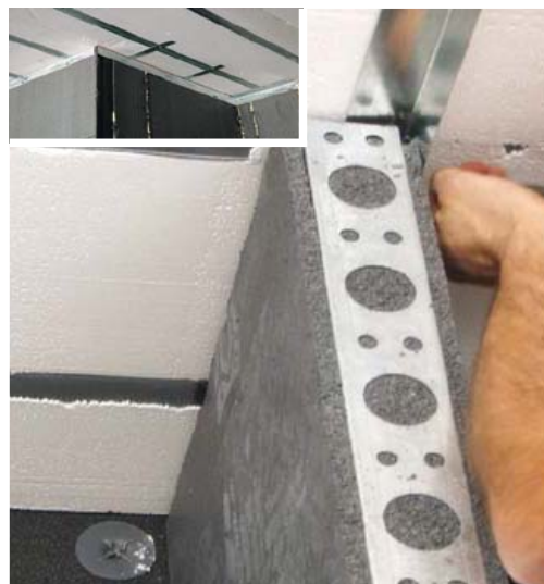
4 Przykręcenie przegrody do profilu
